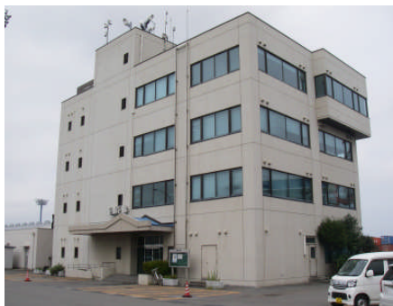
旧東港出張所(県有施設)
